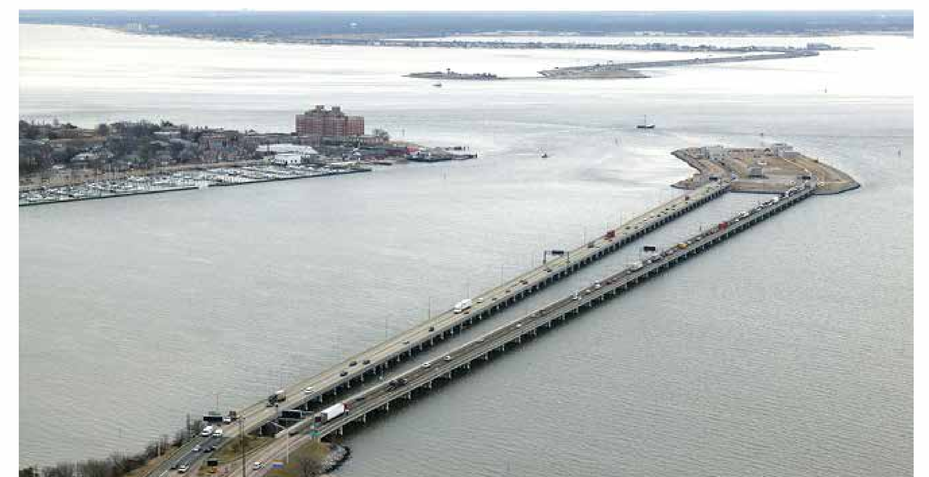
Puente Túnel de Hampton Roads
